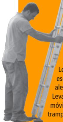
Levante la base de la escalera ligeramente alejándose del edificio. Levante la sección móvil y bloquee las trampas para peldaños.
