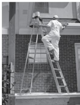
Posicione las escaleras de tijera y otras escaleras auto soportadas de manera que las cuatro patas estén fijas al nivel del suelo. Asegure el tirante en la posición totalmente abierta.
