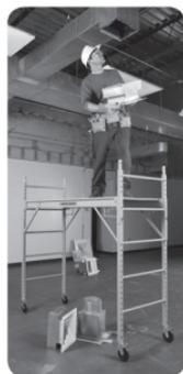
**M (MOVE): MUÉVASE CON PRECAUCIÓN AL ASCENDER Y DESCENDER DE UN ANDAMIO, SIEMPRE UTILIZANDO TRES PUNTOS DE CONTACTO.**
